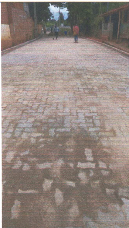
Finalização da pavimentação
