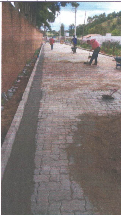
Execução de sarjeta
