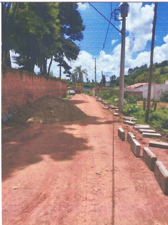
Descarga de material no local da obra
