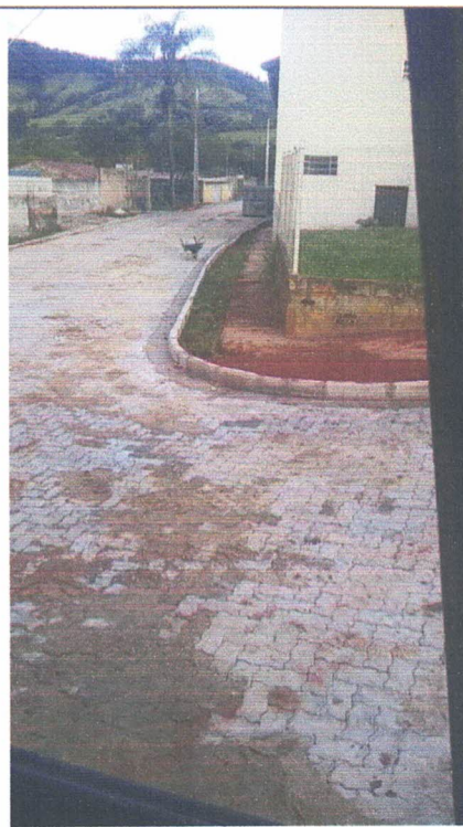
Limpeza da obra
