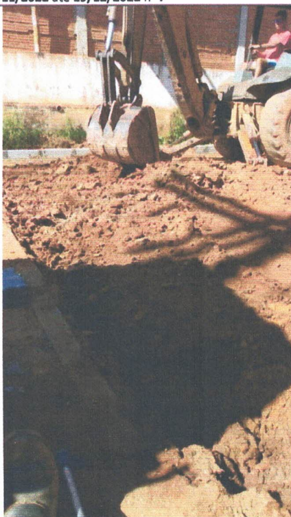
Escarificação do solo para nivelamento
