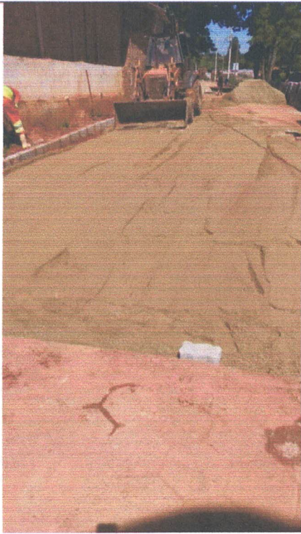
Execução do colchão de assentamento
