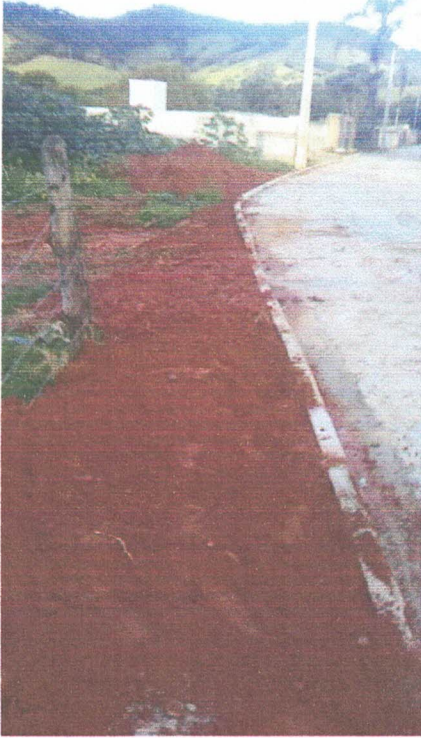
Preenchimento das laterais da pavimentação
