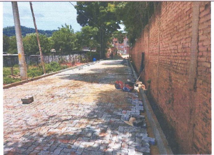
Execução de corte dos pisos intertravados
