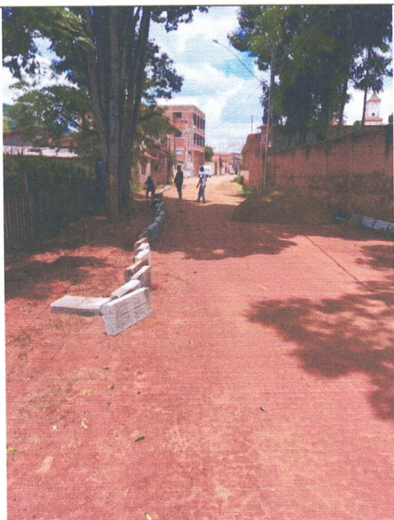
Espalhamento das guias para assentamento
